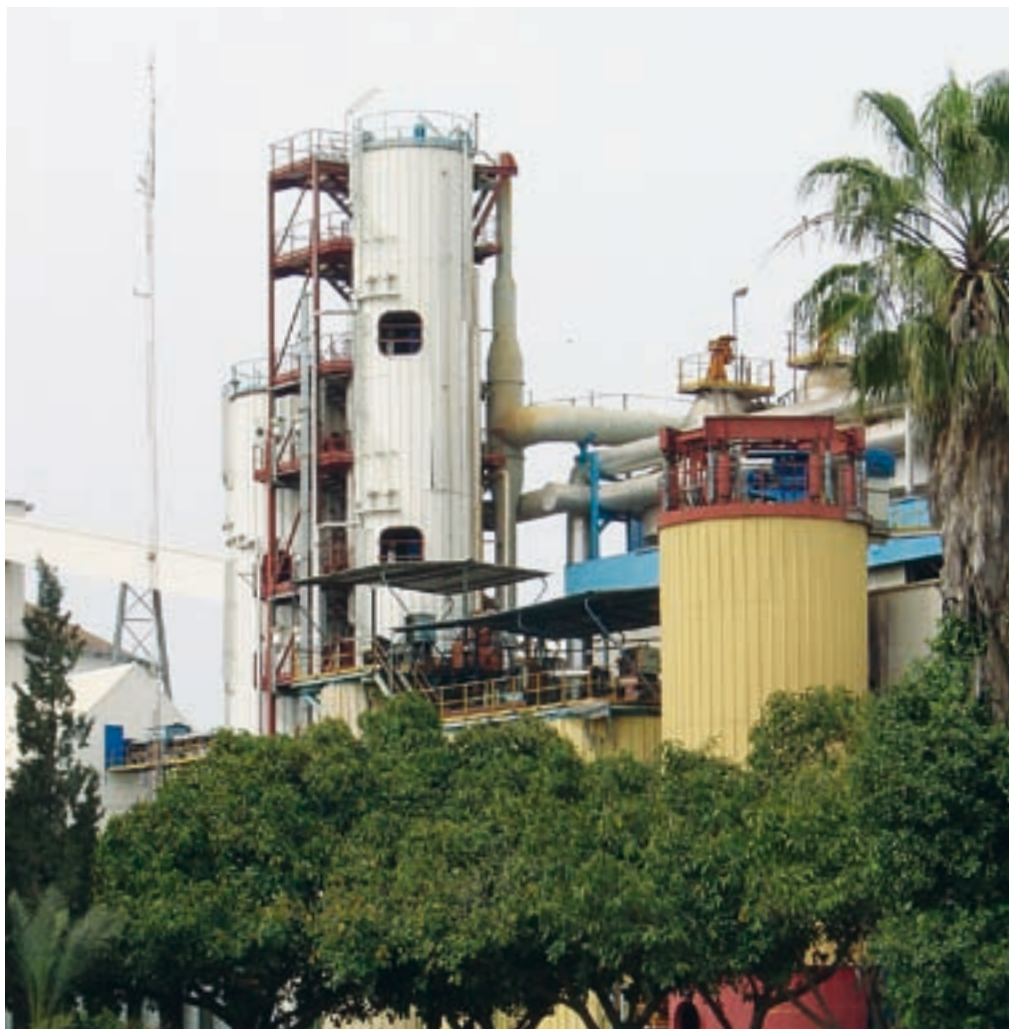
Аппарат VKT для сахара последней кристаллизации
